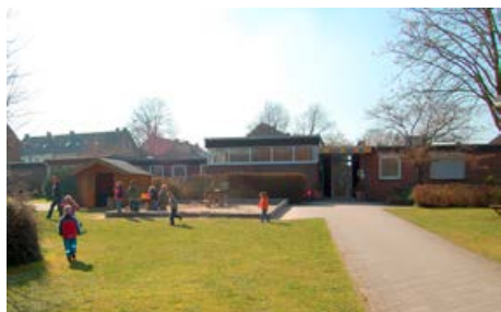
Jakobi-Kindergarten mit großzügigem Außengelände
