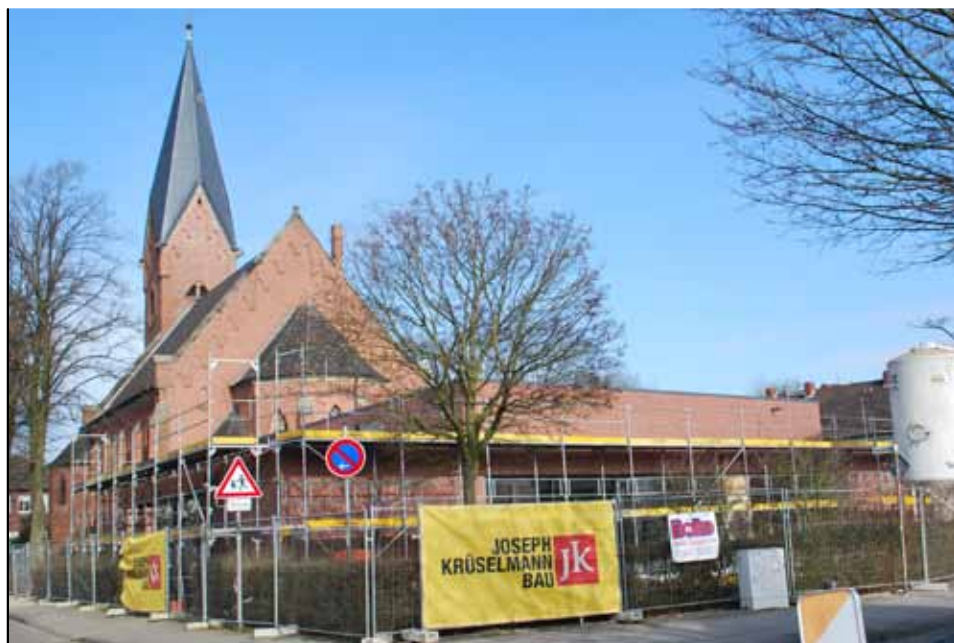
Das Neue Gemeindehaus an der Sternstraße noch als Baustelle
