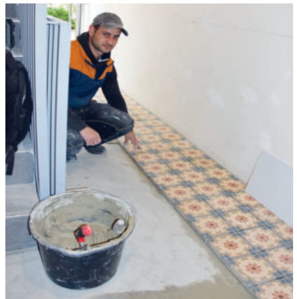
Die Fliesen aus dem alten Haus wurden in Handarbeit von Mörtelresten befreit und jetzt wieder im Eingangsbereich verlegt Foto: R.H.
