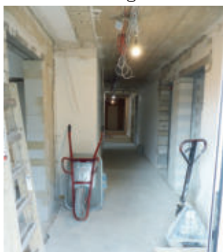
Viele Bereiche wurden von Grund auf renoviert
