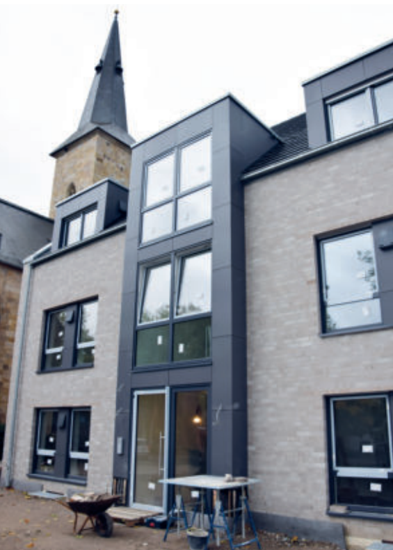
Trotz einiger Widrigkeiten ist der Neubau im November bezugsfertig Foto: R.H.
