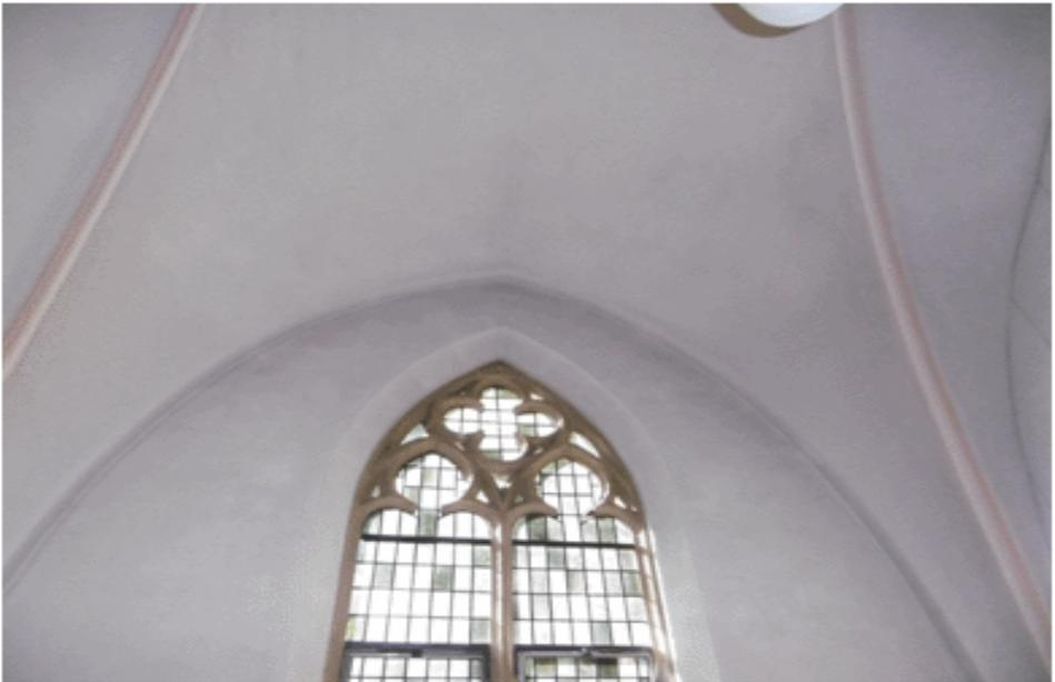
*Insbesondere das „Fogging“, eine Färbung der Wände durch Heizungsluft an kalten Außenwänden, erzeugt im Laufe der Zeit einen dunklen Belag.*
