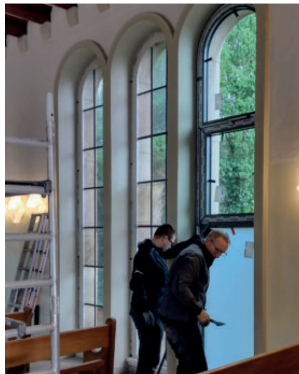
Die Fenster in der Kapelle mussten ausgetauscht werden Foto: K. Wilms
